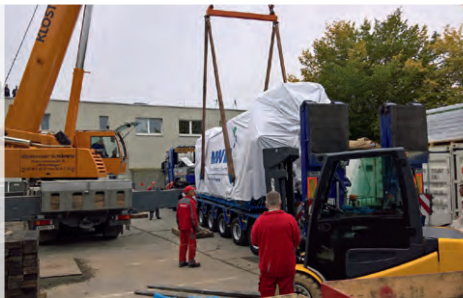
Lieferung des 53 Tonnen schweren MWM Motors für das Blockheizkraftwerk von ETW Energietechnik. Mit einer Leistung von 4,5 Megawatt elektrisch wird rund die Hälfte des gesamten Strombedarfs der Universitätsklinik erzeugt
