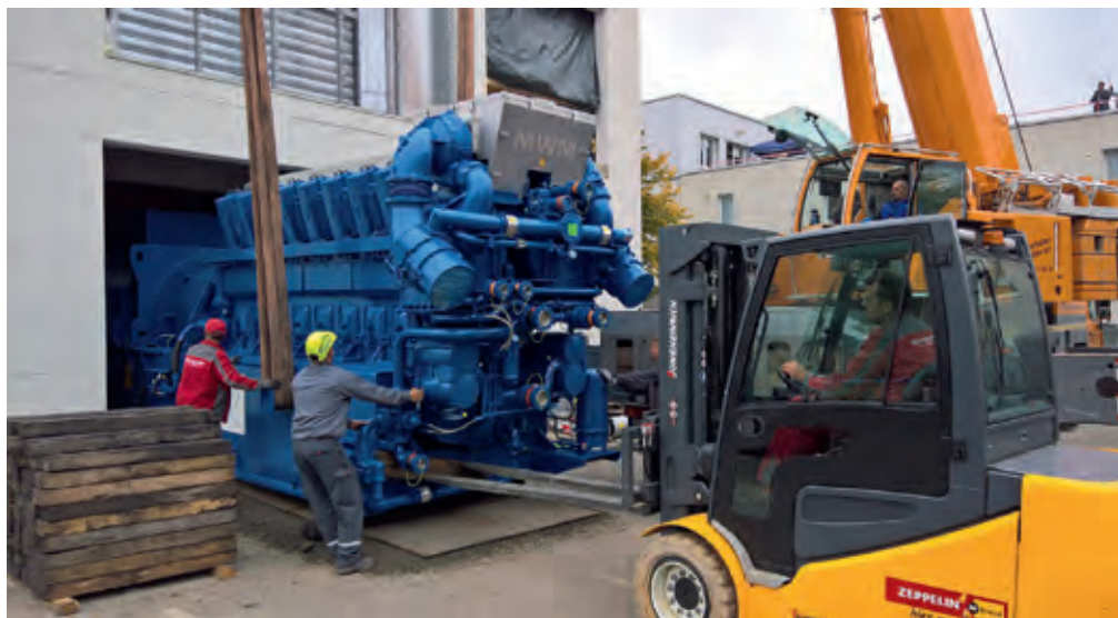
Das Aggregat wird von ETW Energietechnik in ein Gebäude der Universitätsklinik installiert. Der jährliche Wärmeenergiebedarf des Klinikums entspricht dem von 33.000 Privathaushalten. Die Grundlast wird nun von 4,75 Megawatt thermischer Energie aus dem umweltfreundlichen Blockheizkraftwerk versorgt
